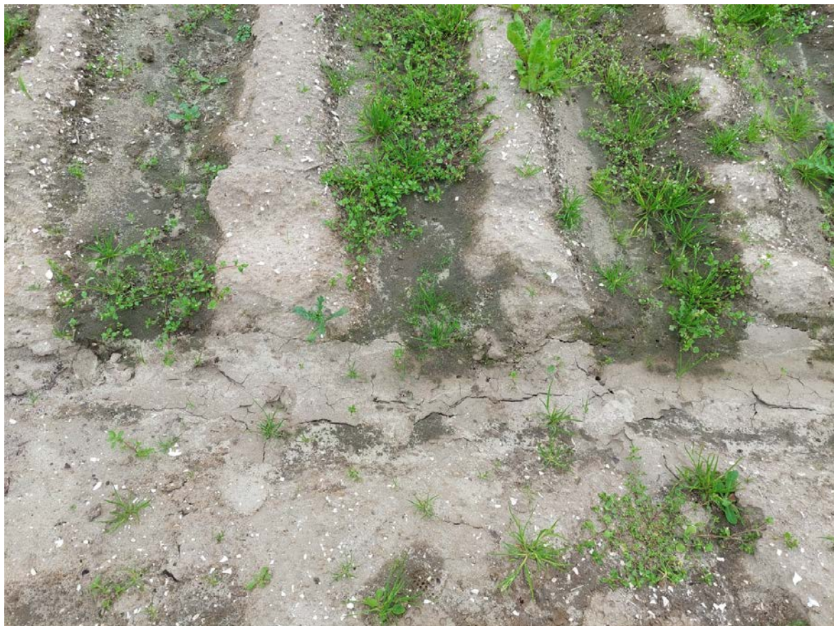
Figuur 4.10 Korstvorming bij de verdiepte, gevulde infiltratiegreppel met bomenzand (foto genomen op 18-08-2023).
