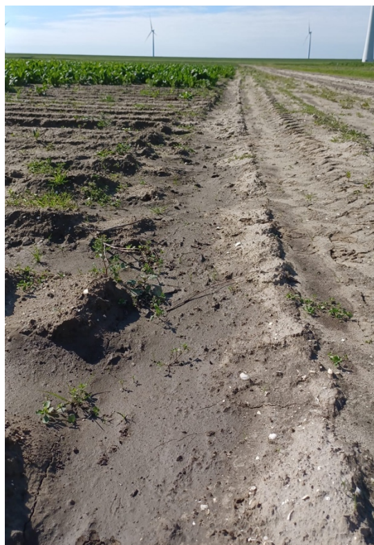
Figuur 4.4 De verdiepte met bomenzand gevulde infiltratiegreppel.
